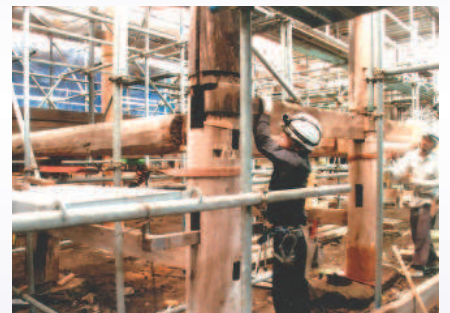
建て直した柱に部材を元通り建て込む
