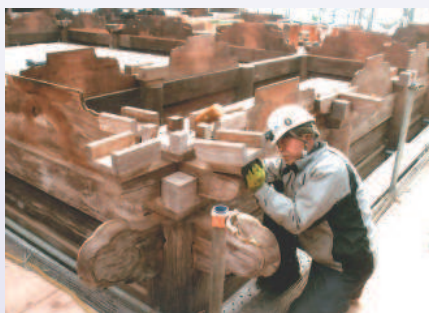
新旧の部材を組み合わせ、一本の柱に
