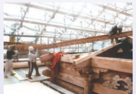
建て直した柱に部材を元通り建て込む
