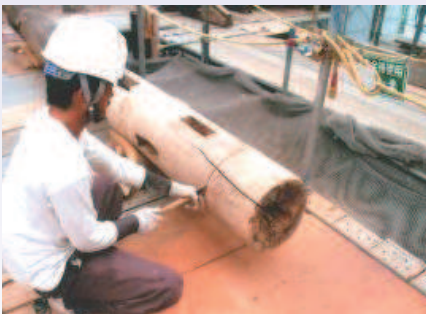
傷みの激しい部分を切り落とす
