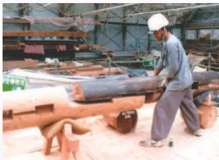
新旧の部材を組み合わせ、一本の柱に
